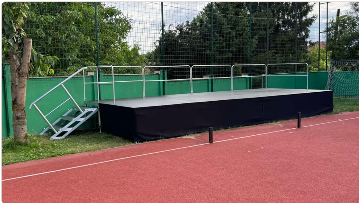
Felállított TS3 színpad szintezett lábakkal, korláttal és lépcsővel.
